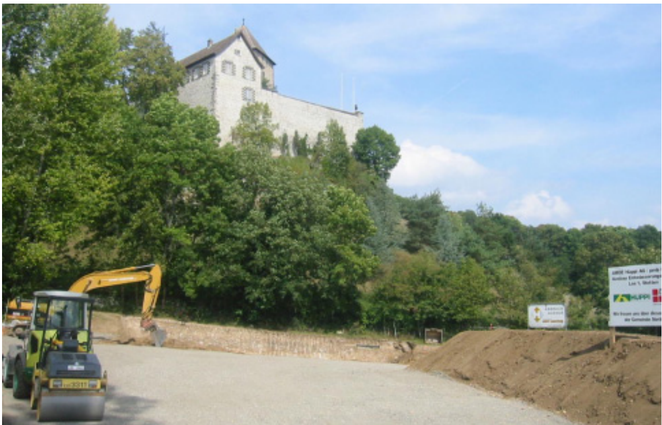
Baubeginn fürs Regenklärbecken unterhalb des Schlosses
